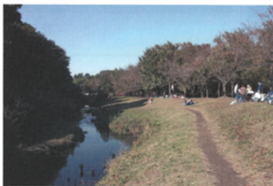
片側の護岸を撤去して水辺空間を創出
