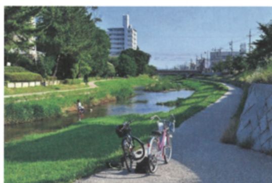
河床幅を拡幅して水辺空間を創出
