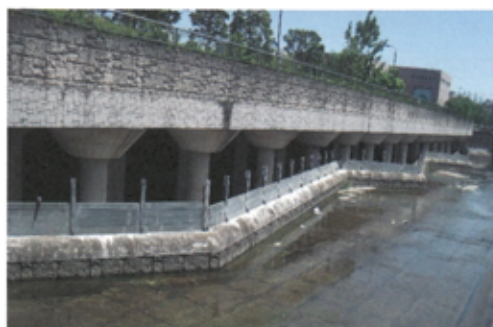
図-1 比丘尼橋下流調節池 （規模 212,000 m 3 ／白子川）
