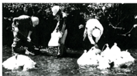
砂利の土嚢作り
